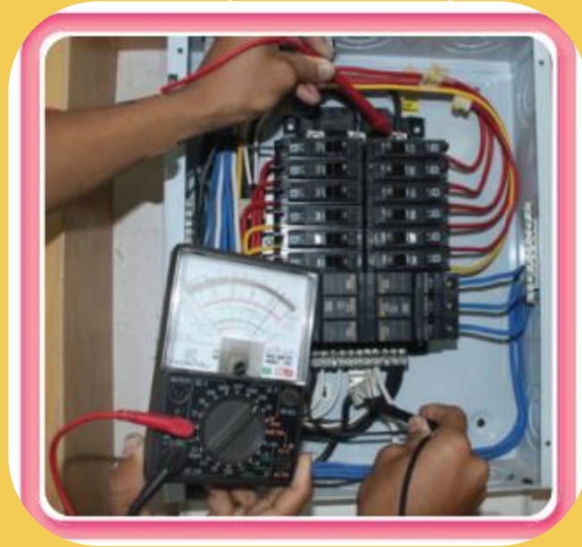
(ข) การตรวจสอบแรงดันไฟฟ้าระหว่างเฟส C กับจุดต่อสายนิวทรัล
