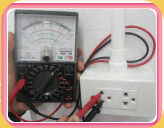
แสดงการใช้มัลติมิเตอร์วัดแรงดันไฟฟ้าระหว่างไลน์กับนิวทรัล
