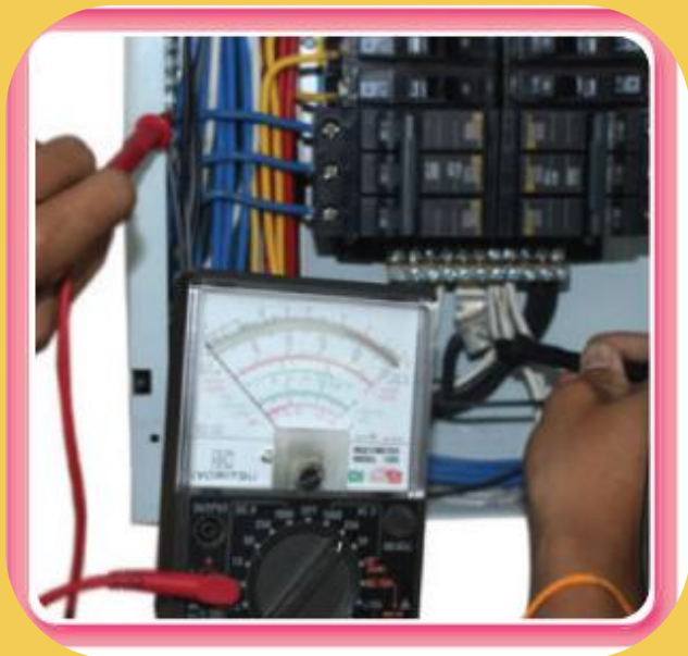
(ก) การตรวจสอบแรงดันไฟฟ้าระหว่างจุดต่อนิวทรัลกับจุดต่อสายดิน
