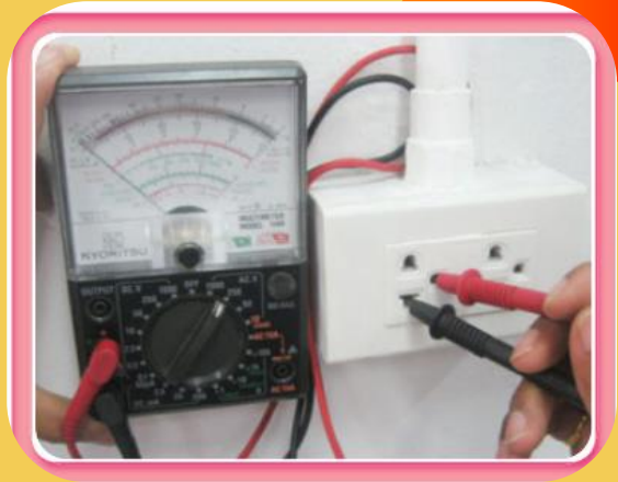
แสดงการใช้มัลติมิเตอร์วัดแรงดันไฟฟ้าระหว่างนิวทรัลกับสายดิน
