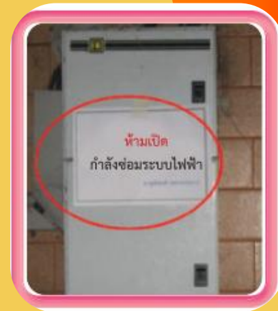
แสดงการติดป้ายแจ้งเตือน ขณะซ่อมระบบไฟฟ้า
