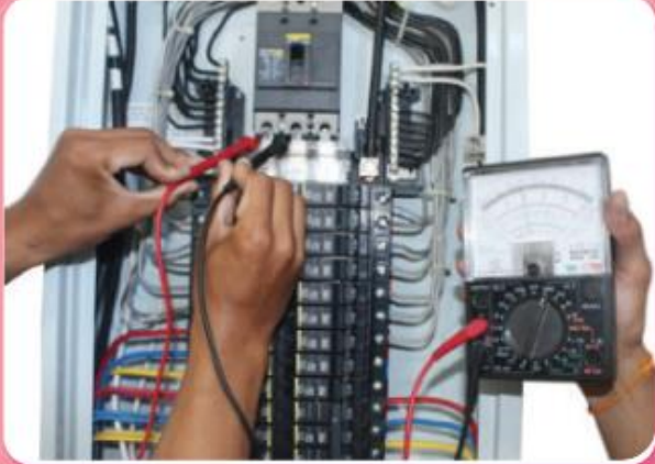
การวัดแรงดันไฟฟ้า ระหว่างเฟส A กับเฟส B
