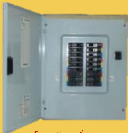
โหลดเซ็นเตอร์ แบบเมนลัก (Main Lug)
