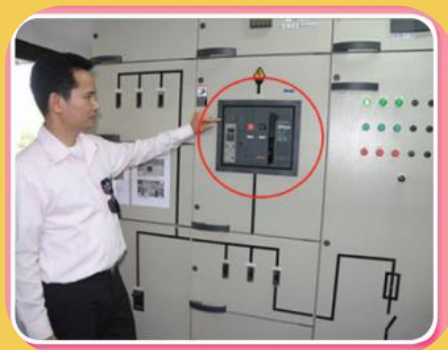
(ข) ตัวอย่างการใช้งานแอร์เซอร์กิตเบรกเกอร์ แบบติดตั้งอยู่กับที่
