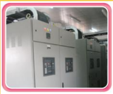
(ก) การติดตั้งภายในอาคาร
